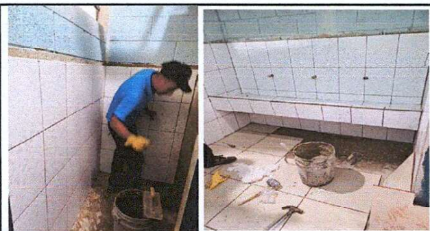
Foto 3: baños en proceso de remodelacion.
